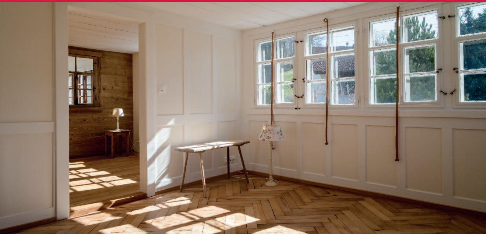
Stube und Nebenstube im ursprünglichen Materialkanon nach der Renovation; geölte Holzböden, mit Ölfarbe gestrichene Tüfelung, renovierte Altfenster und freigelegte Strickwand im Hintergrund
